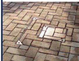
Il chiusino è composto da un telaio in lamiera zincata pressopiegata atto a contenere i masselli autobloccanti. Con vasca interna accessoriata negli angoli da boccole di fissaggio, per favorire una corretta adesione ed un perfetto bloccaggio tra interno e telaio. Questo particolare sistema di imbullonatura comprime la guarnizione ottenendo così una perfetta ermeticità.
