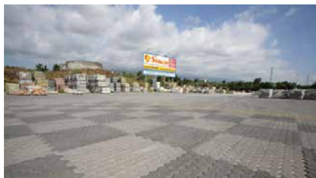
Deposito di Acireale (CT)
